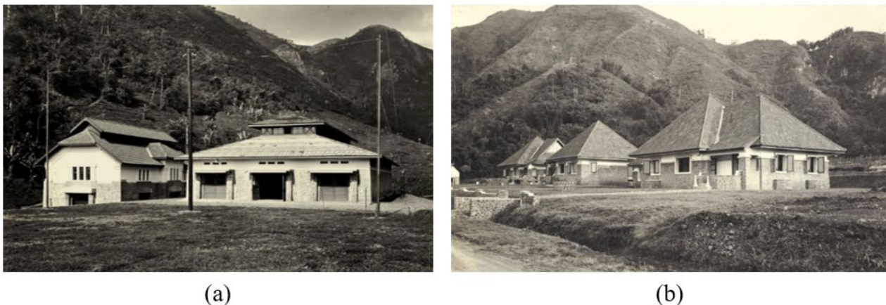
Figure 1. (a) Radio transformer building (left) and transmitter building (right) (b) Official residence (Dientswoning) Source: Radio Malabar: herinneringen aan een bloeiende tijd 1914-1945 / Klaas Dijkstra. - Groenlo : Emaus, 2006
